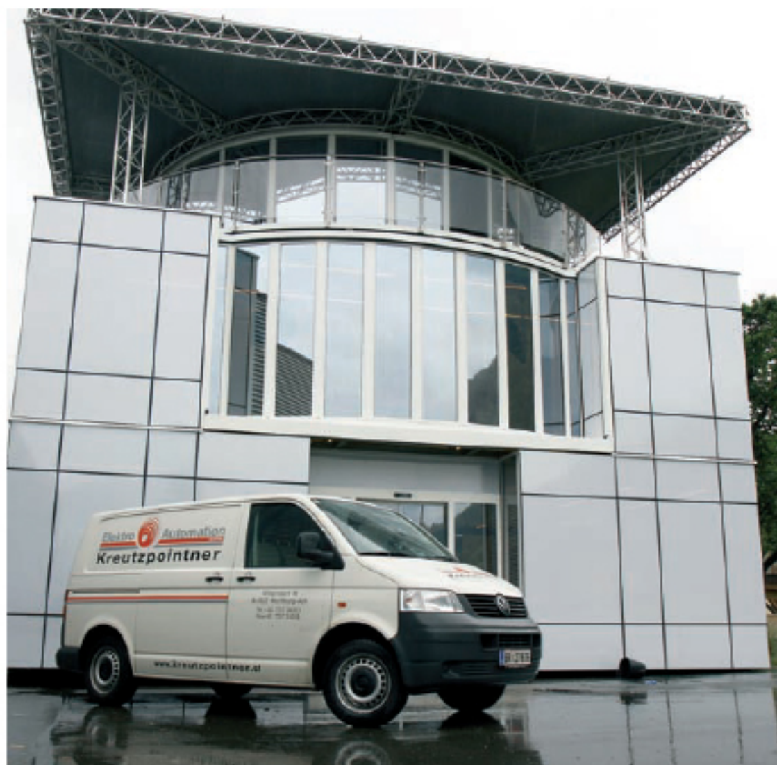
EAK zeigt zunehmend Präsenz bei technisch herausforderungsvollen Projekten: So sieht das transportable Motorhome im fertig montierten Zustand aus.
