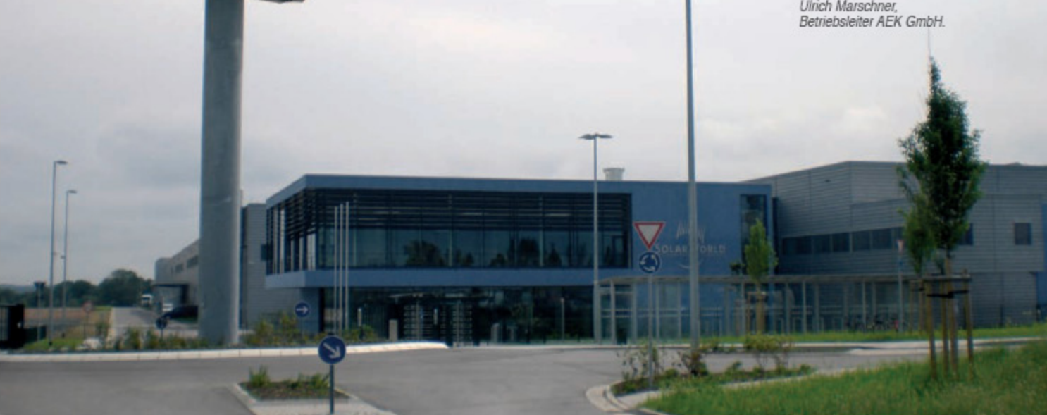
SolarWorld in Freiberg/Sachsen: AEK Automation Elektro Kreuzpointner GmbH war beim Projekt für eine neue Solarwafer-Fertigung federführend bei der finalen E-Installation.
