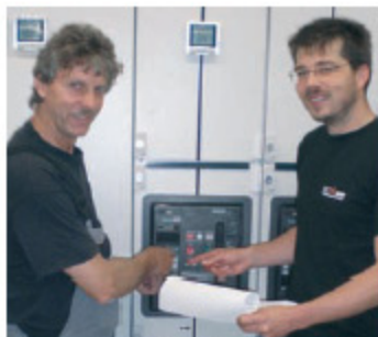
Hoch motiviertes AEK-Team beim Projekt SolarWorld: Bauleiter Enrico Galle (rechts) und Monteur Bernhard Herischek bei der Parametrierung von Hochstromschaltern.
