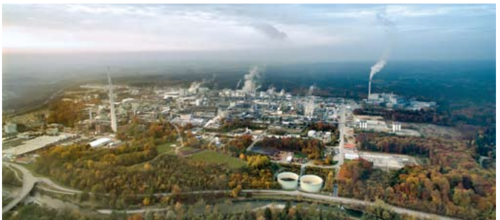
Bis zu 400 EFK-Industrietechniker halten routiniert die großen Werke der Kunden EMSR-technisch in Schwung – wie zum Beispiel im Chemiepark Gendorf in Burghausen. (Foto: Gendorf)
