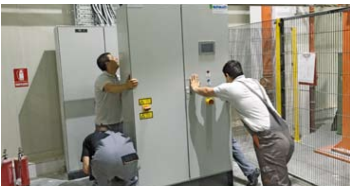
Aufstellen der Schaltschränke von Firma Scheuch im bulgarischen Sevlievo.
