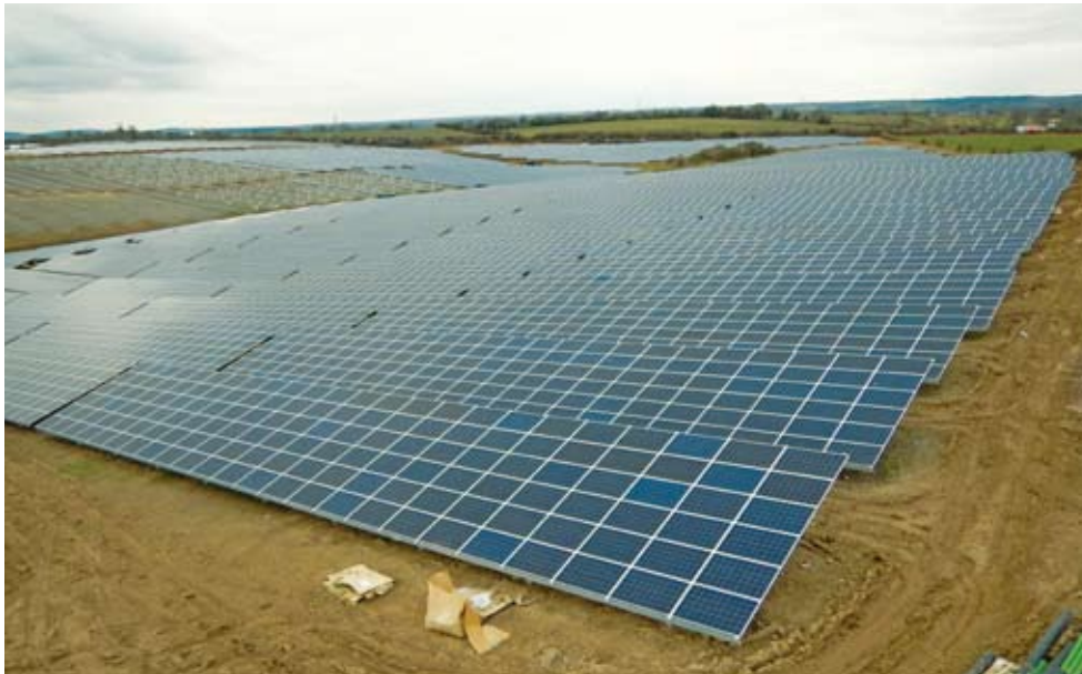
Gewaltige Dimensionen: Der Solarpark Cow Down bei Andover in Südengland befindet sich auf einer Fläche von über 100 Hektar und erzeugt 40 MWp elektrische Leistung.
