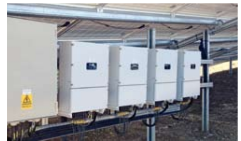
Blick auf einen AC-Sammler - 594 Wechselrichter wurden innerhalb nur eines Tages ans Netz gebracht.
