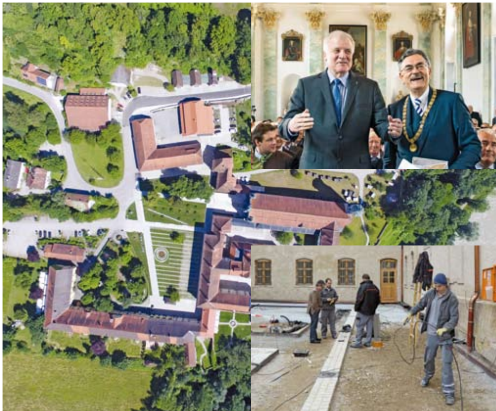
Gebäudetechnik und Schaltanlagen von Elektro Kreuzpointner für das Study & Science Center Raitenhaslach: Im Juni wurde es offiziell von Ministerpräsident Horst Seehofer und TUM-Präsident Prof. Wolfgang A. Herrmann eröffnet. Unser Projektteam war in Raitenhaslach von Herbst 2014 bis Ende Juni 2016 im Einsatz. (Fotos: TUM/EFK)
