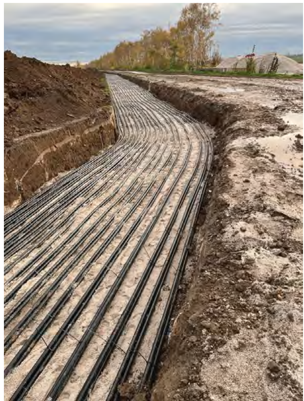
Insgesamt an die 150 km Kabelgraben inklusive Kabelzug muss das Baustellenteam von Kreuzpointner energy für den Solarpark Witznitz vornehmen. Hier der aktuelle Kabelgraben, der allein 1,5 km lang ist.
