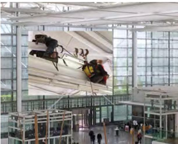
Fast 1.000 LED-Leuchten wurden vom Montageteam in den Hallen des Terminals 2 in Höhen bis zu 30 Meter installiert – und das nur nachts.
