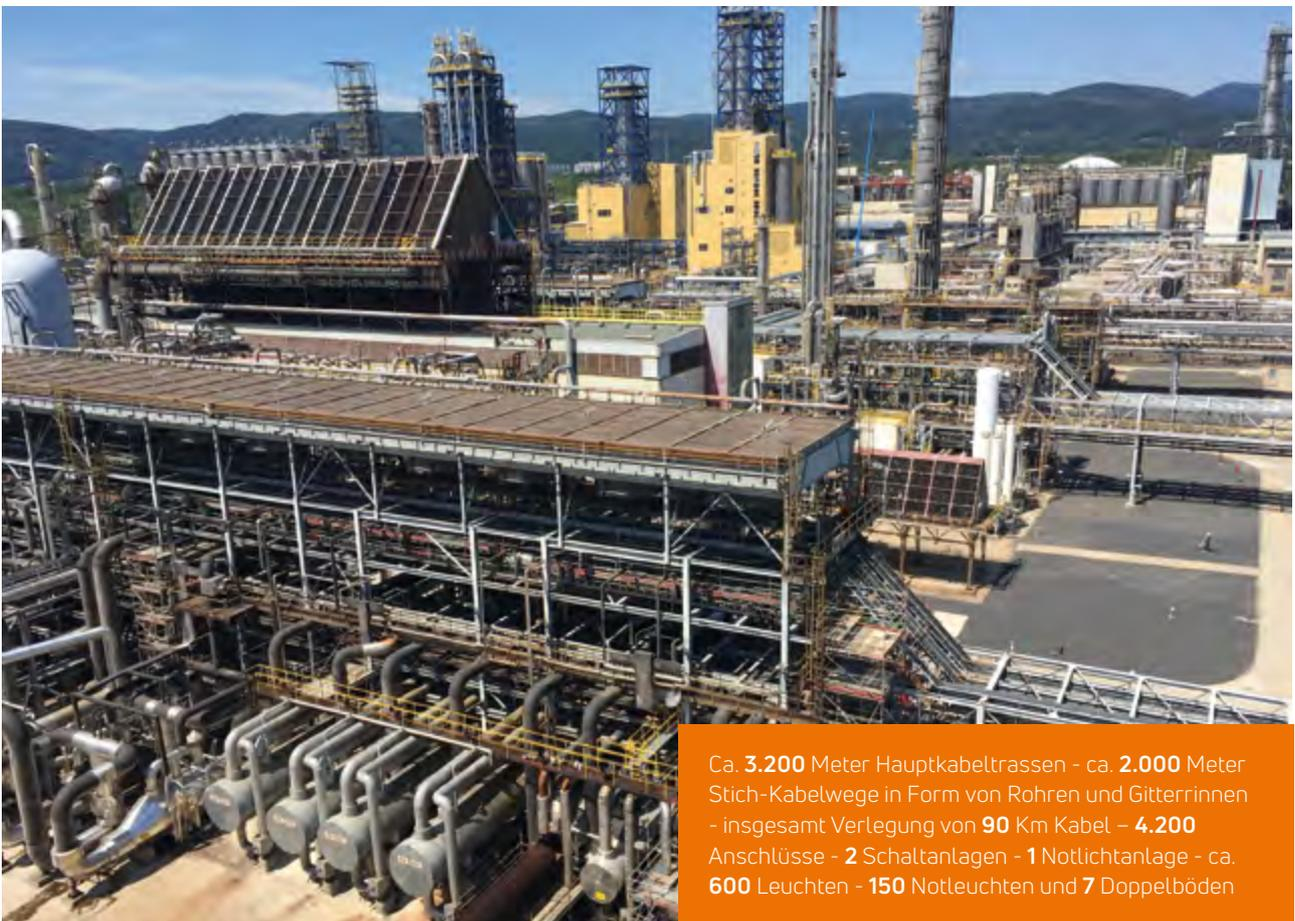
Ca. **3.200** Meter Hauptkabeltrassen - ca. **2.000** Meter Stich-Kabelwege in Form von Rohren und Gitterrinnen - insgesamt Verlegung von **90** Km Kabel - **4.200** Anschlüsse - **2** Schaltanlagen - **1** Notlichtanlage - ca. **600** Leuchten - **150** Notleuchten und **7** Doppelböden
