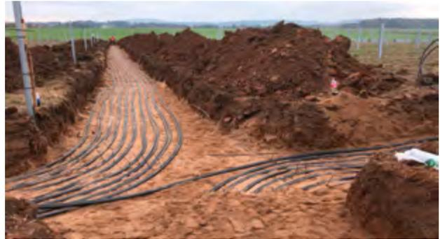
Kabelgräben mit bis zu 2,5 m Breite für den Österberg-PV-Freiflächenpark.
