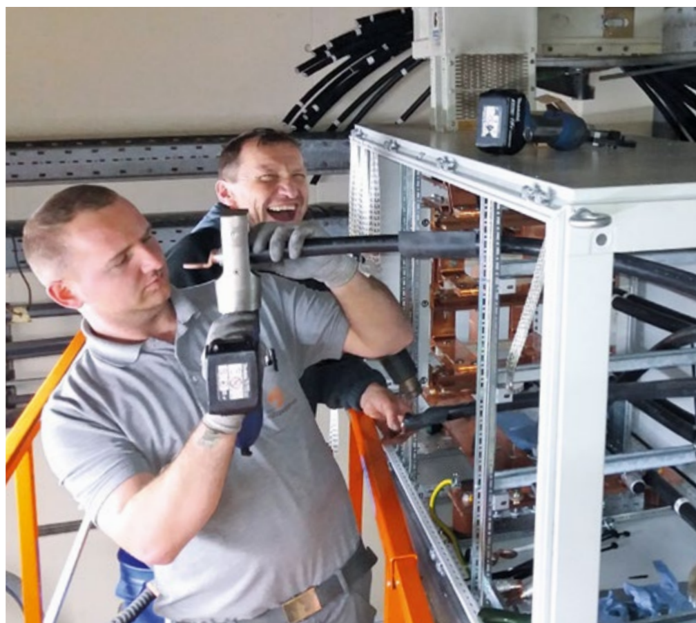
Voll in Action und gut drauf trotz Einsatz während der Urlaubszeit: (vorne) Lorenz Steiner (EKA) und Michael Baumann (Industrietechnik-Stützpunkt Wacker-Werk Burghausen) vom freiwilligen Kreuzpointner-Einsatzteam bei den Anschlussarbeiten.
