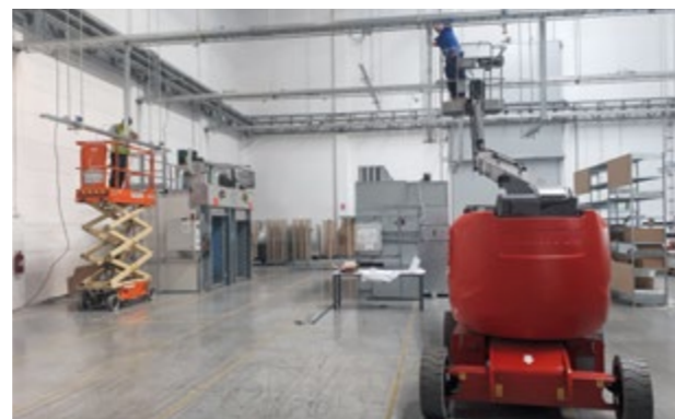
Beim Elektrotechnik-Projekt in der Nähe von Brasov.
