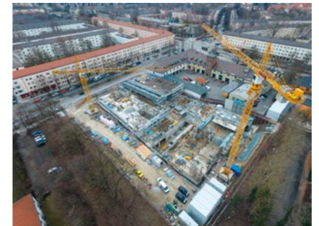
So schaut es derzeit an der Großbaustelle in Ramersdorf aus – Bauabschnitt 1 ist seit Oktober die „Spielwiese“ für unsere Münchner Gebäudetechniker.
