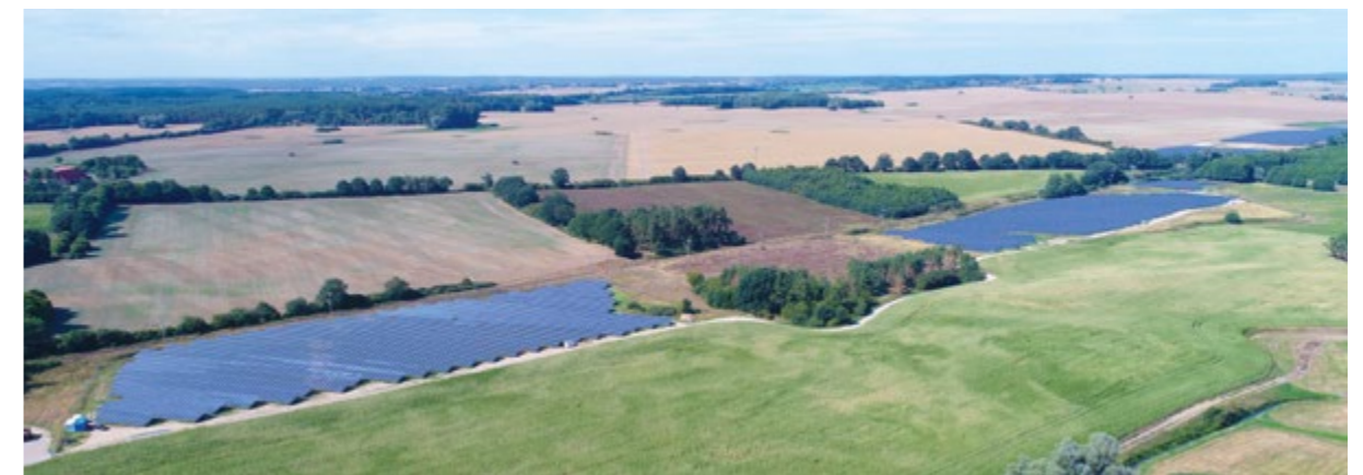
Die kürzlich von Kreuzpointner energy fertiggestellte PV-Anlage im brandenburgischen Blankensee mit 6MWp Leistung erstreckt sich über mehrere Felder fast bis zum Horizont.
