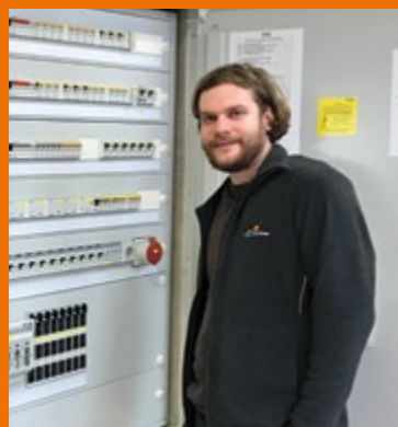
Techniker Marco Klein und das EKA-Team führten das Jahn-Schulzentrum in Linz einen wichtigen Schritt weiter in Richtung Digitalisierung.
