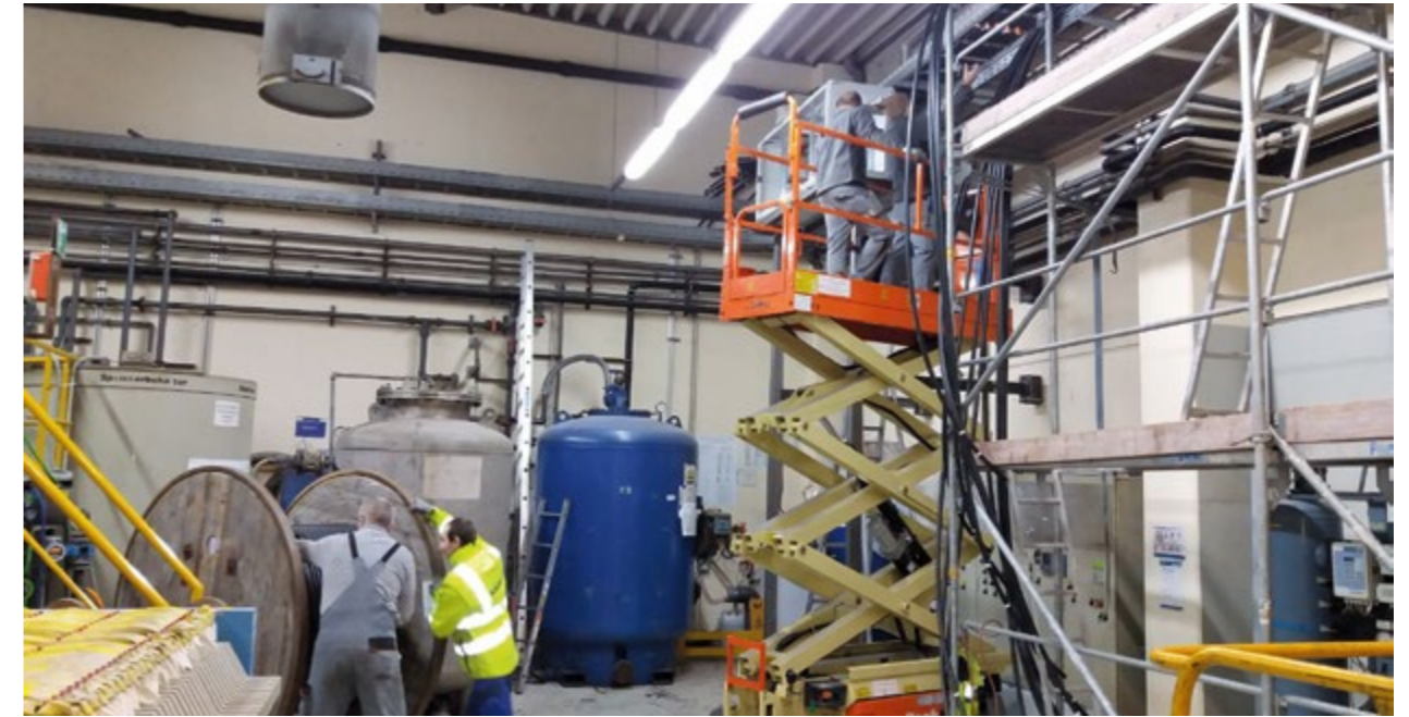
Innerhalb von nur drei Tagen gelang es dem Kreuzpointner-„Einsatzteam“ die Anlage elektrotechnisch wieder flott zu machen – hier bei der Verlegung der Leitung.
