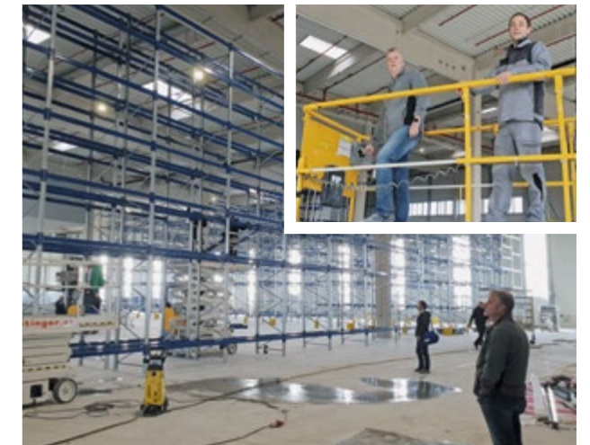
Schwindelfreiheit vorausgesetzt wurde bei der Montage in 12 Meter Höhe. Kleines Bild: Auch Projektleiter Manfred Rösch (li.) und Bauleiter Markus Janny mussten immer wieder mal „rauf“.
