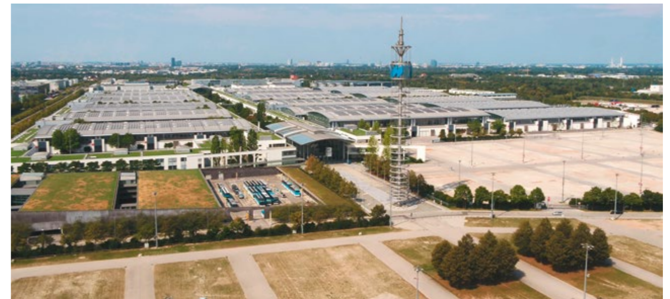
Zwei jeweils 10.000 m 2 große Messehallen – hier rechts im Bereich der Hallen – wurde mit Kreuzpointner-Gebäudetechnik und Schaltanlagen aus Burghausen ausgestattet.
