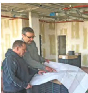
Bauleiter Hans Rötzer (re.) vor Ort mit einem Nachunternehmer-Monteur.
