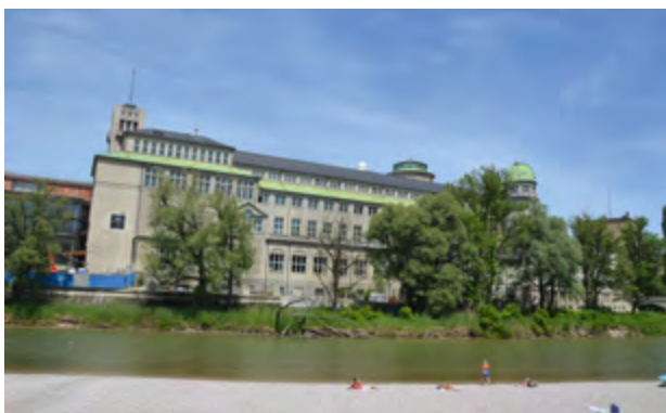
Deutsches Museum München: Großprojekt für unsere Geschäftsbereiche Gebäudetechnik und Schaltanlagenbau.
