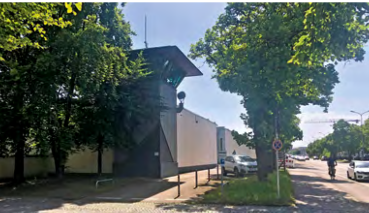
Hinter den Mauern der JVA Stadelheim kommt Kreuzpointner-Technik zum Einsatz.
