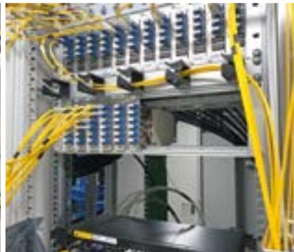
IT LAN-Verteilertechnik in 19". Baugruppenträger und 6x SC Duplex Kompaktmodule E9/125µ OS 2.
