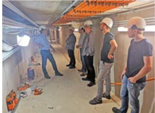
Besichtigung der von der Gebäudetechnik installierten Funktionserhalt-Kabelwege für die Sicherheitsstromversorgung im neuen Funktionstrakt Nord durch die Gebäudetechnik-Projektverantwortlichen und die involvierten Planungs-Kollegen der Ingenieurtechnik: (v.l.) Projektmanager Fritz Rottler, Thomas Hintermeier, Bauleiter Hans Ammer, Peter Eckerl, Franz Wierer und Manuel Brandl.
