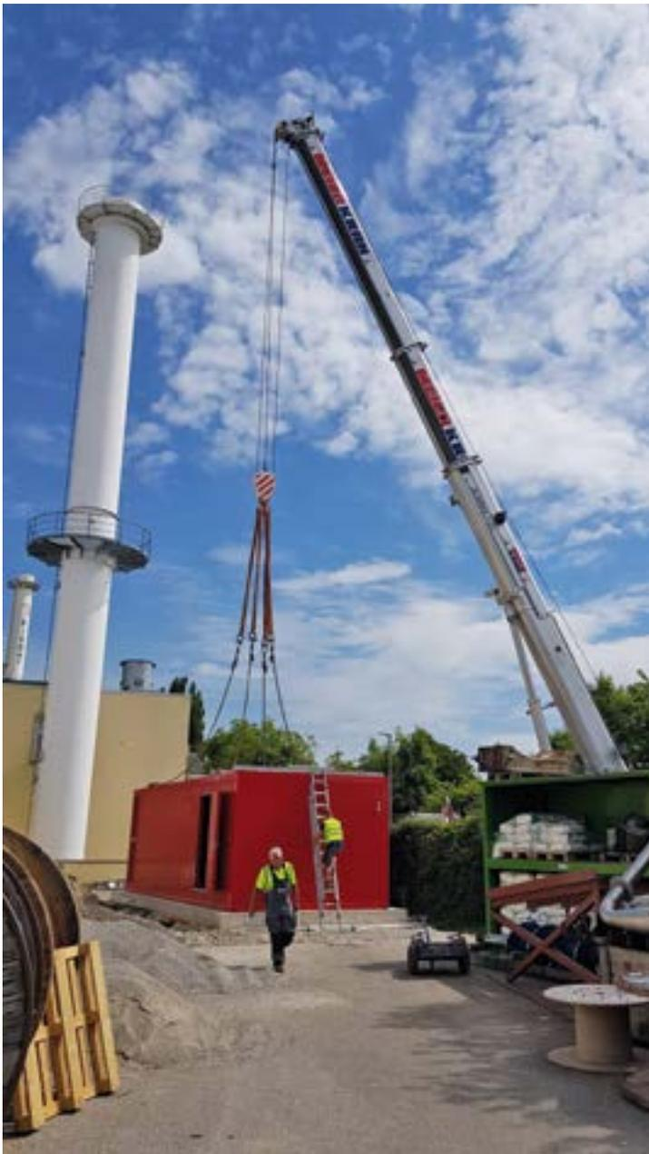
Das 16 Tonnen schwere Aggregat, verbaut in einem Schiffscontainer, musste mit einem Sondertransport aus der Nähe von Frankfurt zur Papierfabrik in Trostberg geliefert werden.
