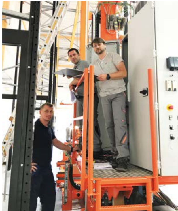
Vormontage in Trostberg: (v.l.) Alztec-Bauleiter Zsolt Nagy, Josef Rothenbuchner (Bauleiter EKA) und Thomas Starka (verantwortlicher EMSR-Planer).
