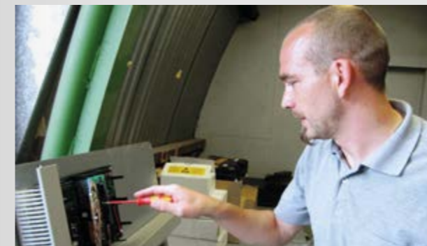
Inbetriebnahmetechniker Andreas Heim beim Aufbau von einem der insgesamt 40 Notrufserver.
