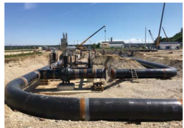
Bauarbeiten von der Einbindestelle an die Molchstation Haiming zur Leitungstrasse MONACO
