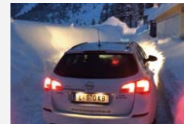
Enorme Schneemengen an der Baustelle in über 2.000 Meter Höhe.
