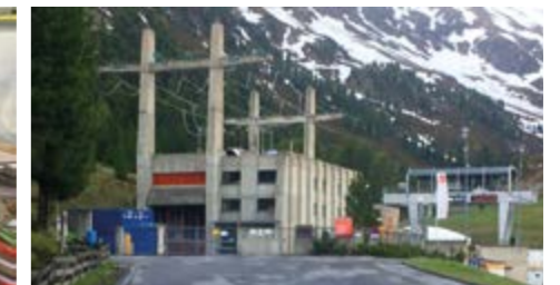
Das Umspannwerk des Kraftwerks Kühtai.
