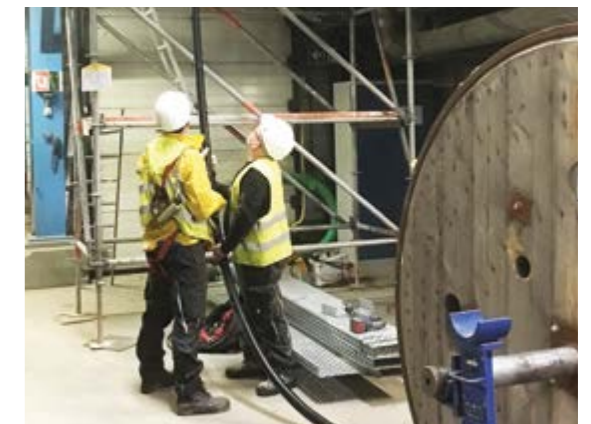
Einspeisung und Anschließen der Kabel.
