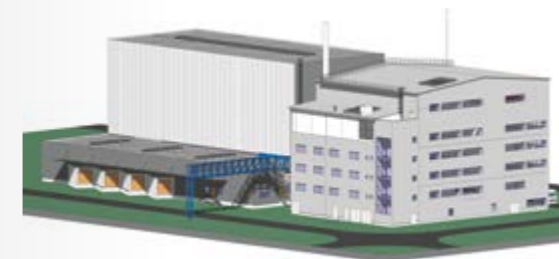
Die AlzChem-Anlage in der Planungs-Visualisierung: Im vorderen Gebäudeteil befindet sich die Produktionsanlage, hinten die Logistikhalle mit Palettierung, Hochregallager und LKW-Terminal.
